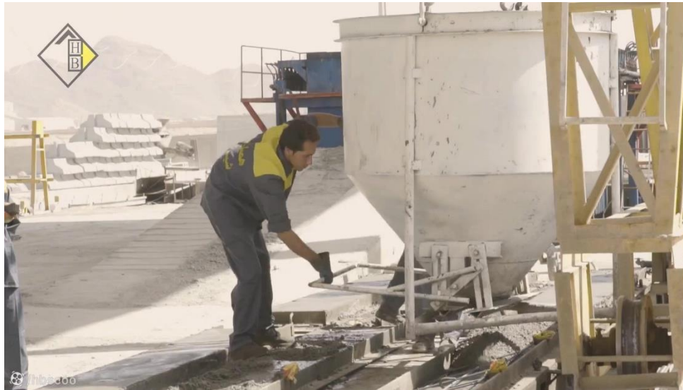
شکل ۵: انتقال بتن از تراک میکسر به محفظه‌های بتن‌ریزی
