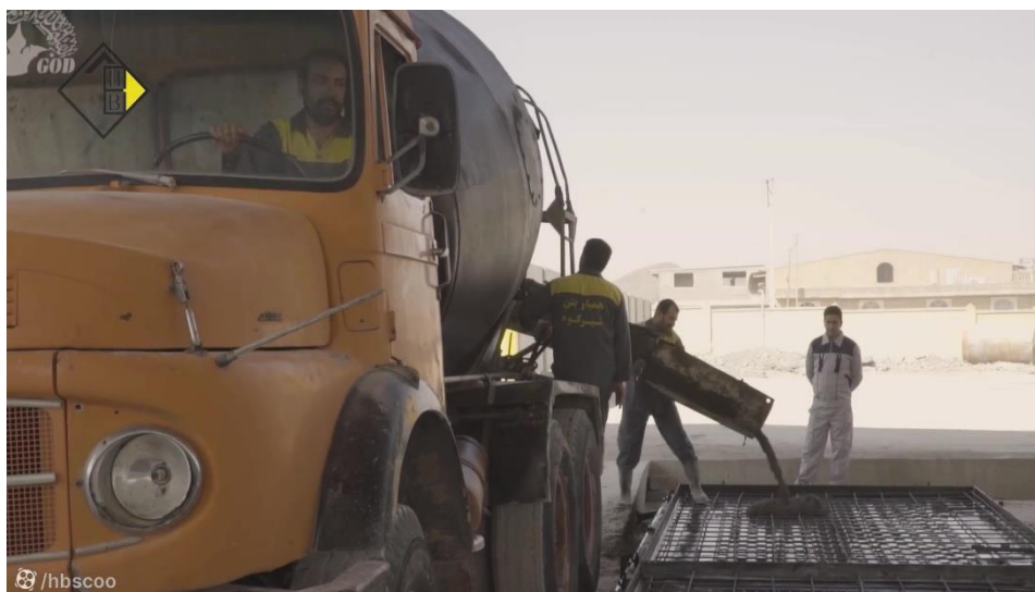
شکل ۵: انتقال بتن از تراک میکسر به قالب‌ها
