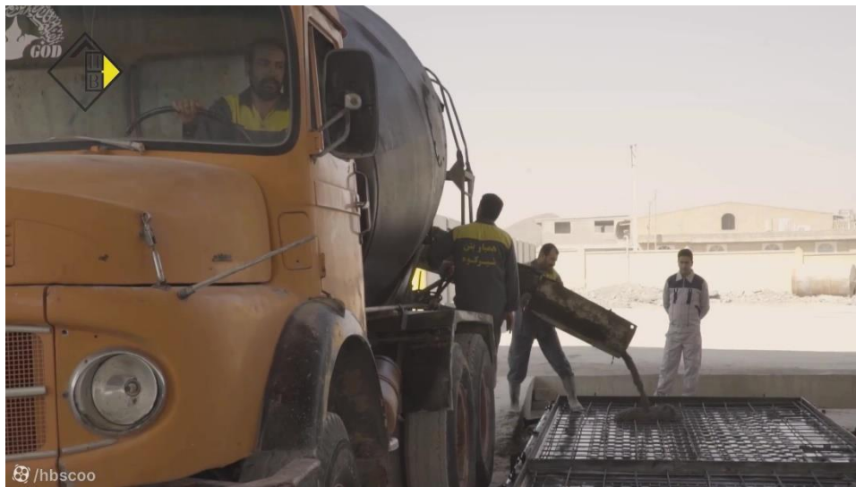
شکل ۵: انتقال بتن از تراک میکسر به قالب‌ها
