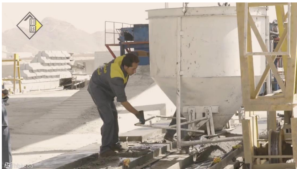
شکل ۶: انتقال بتن از تراک میکسر به محفظه‌های بتن‌ریزی
