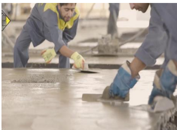
شکل ۲: بتن‌ریزی و پرداخت سطح قطعات پس از بتن‌ریزی
