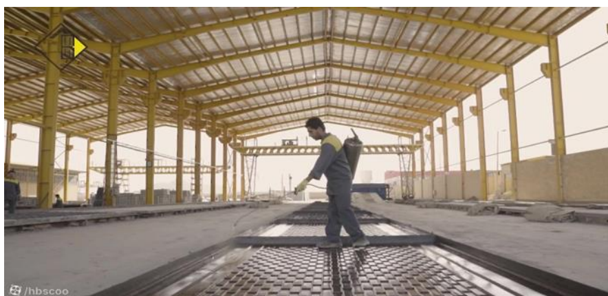
شکل ۱: پاشش روغن قالب بر روی سطح قالب‌ها
