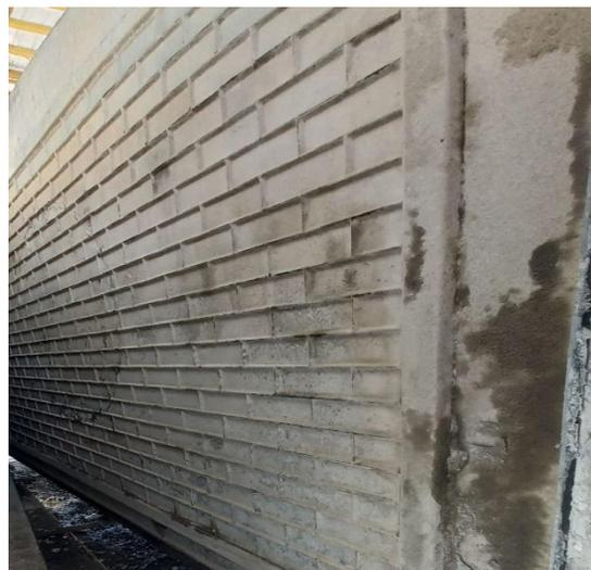
شکل ۵: رسوبات تشکیل شده بر روی قالب‌های دیوار بتنی پیش‌ساخته
